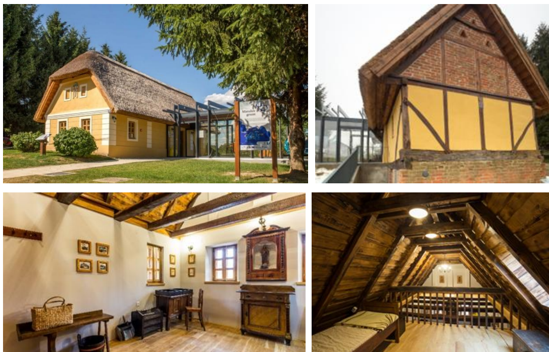
Slika 4. Stanje kuće nakon sanacije i revitalizacije, Matulov grunt, Frkanovec
