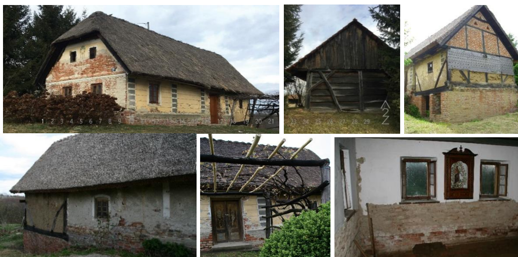
Slika 3. Stanje kuće prije sanacije i revitalizacije, Matulov grunt, Frkanovec
