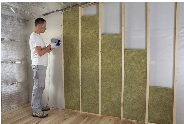
Zidna obloga na drvenoj potkonstrukciji
