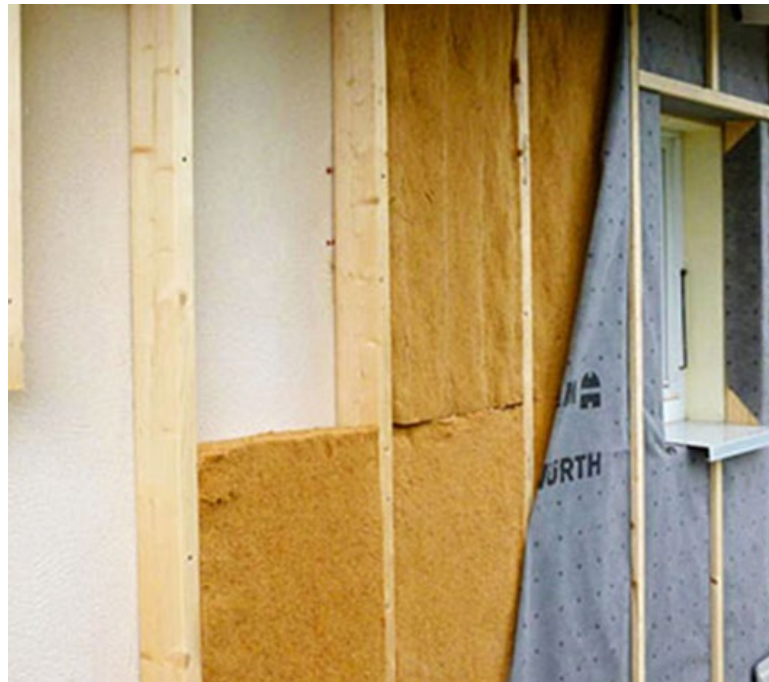
Toplinska izolacija i parna brana na vanjskom zidu
