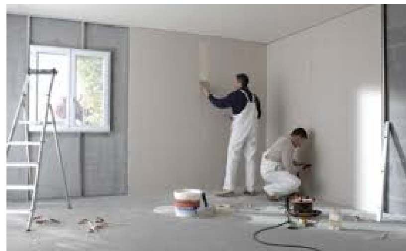
Zidna obloga na metalnoj potkonstrukciji
