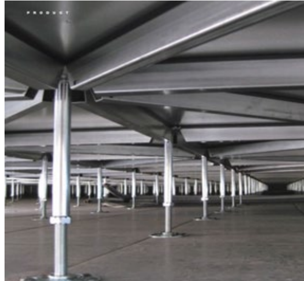
Nosiva konstrukcija uzdignutog poda
