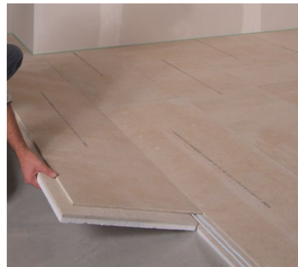
Postavljanje višeslojnih gipsvlaknastih ploča direktno na nosivu konstrukciju
