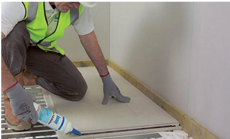
Lijepljenje višeslojnih gipsanih ploča
