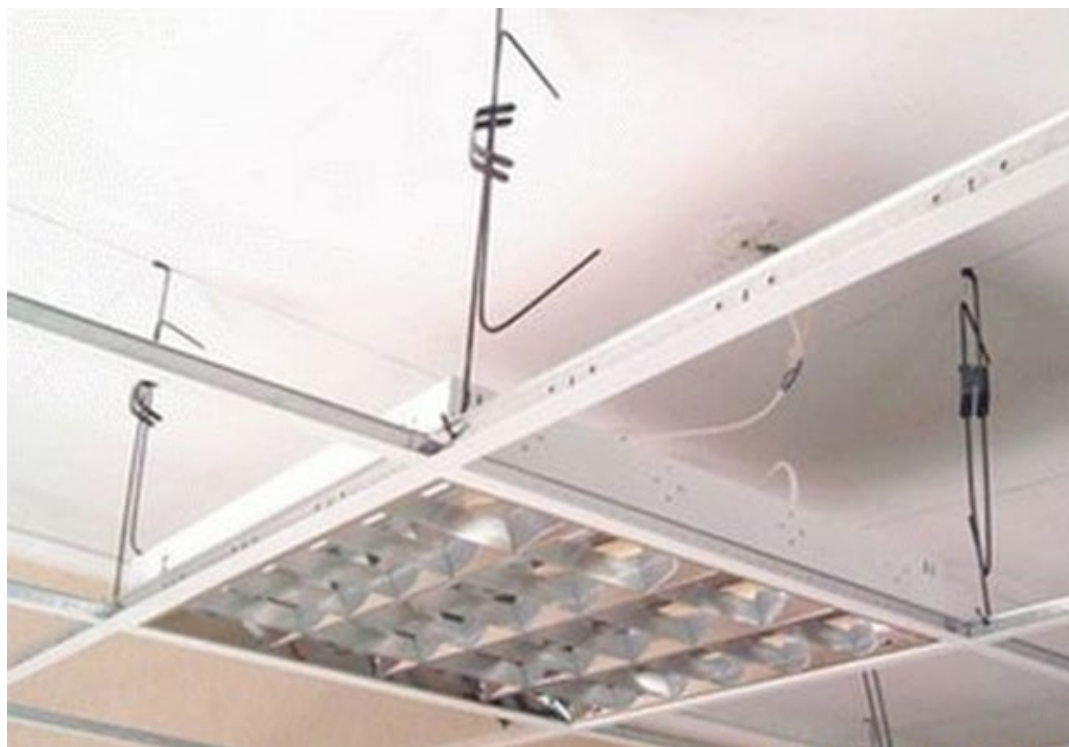
Viseća potkonstrukcija modularnog spuštenog stropa
