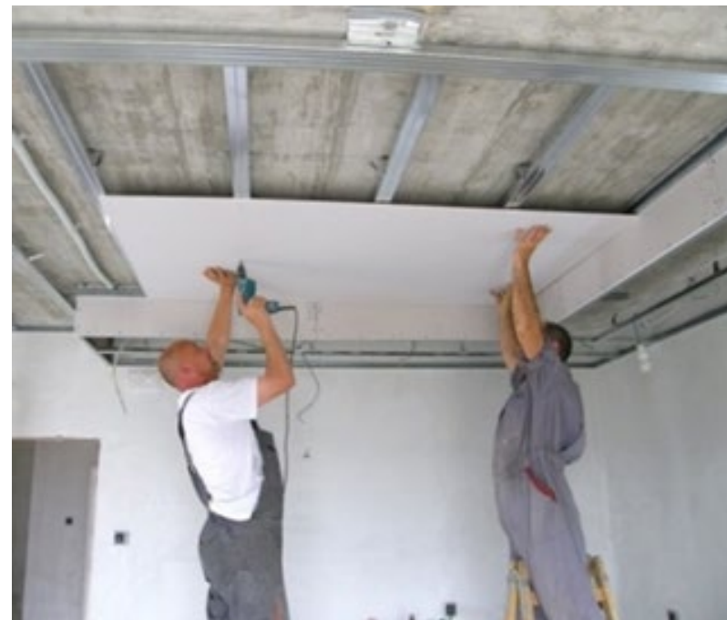
Izvedba spuštenog stropa s direktnim pričvršćenjem potkonstrukcije
