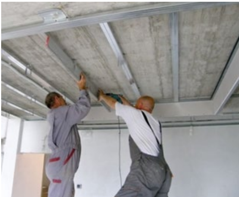
Izvedba spuštenog stropa s direktnim pričvršćenjem potkonstrukcije
